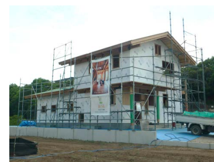
4月吉日に上棟したN様邸。現在は内部も少しずつ工事が進んでいます。
